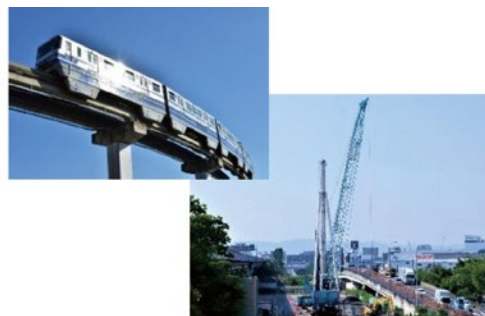
大阪モノレール支柱建設工事 (桑才新町工区)
