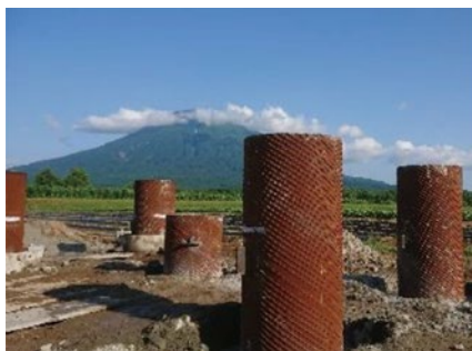
北海道新幹線 鋼管ソイルセメント杭施工試験
