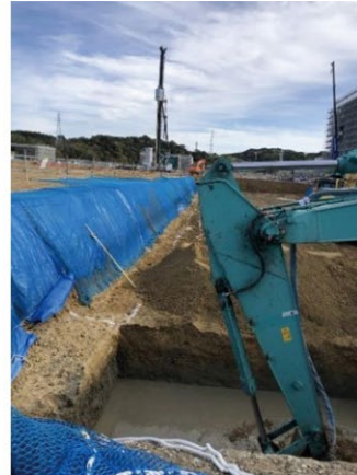
テノキューブとテノコラムの併用施工
