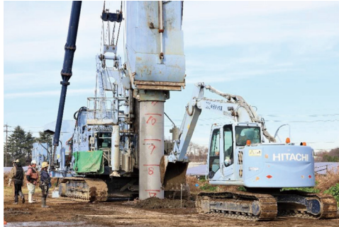
新コンクリート中掘り杭工法
