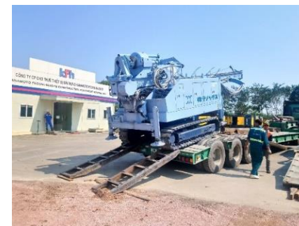
施工機がベトナムに到着
