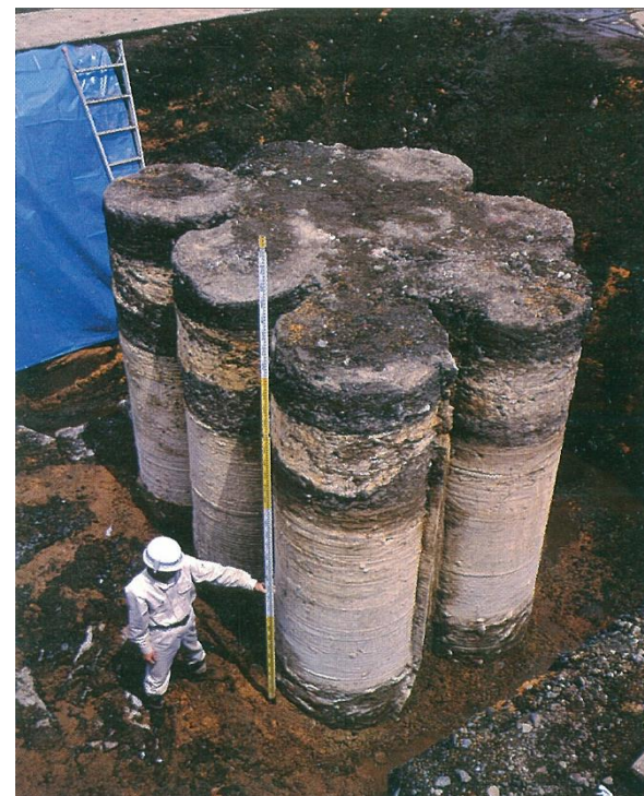
地盤改良工法
