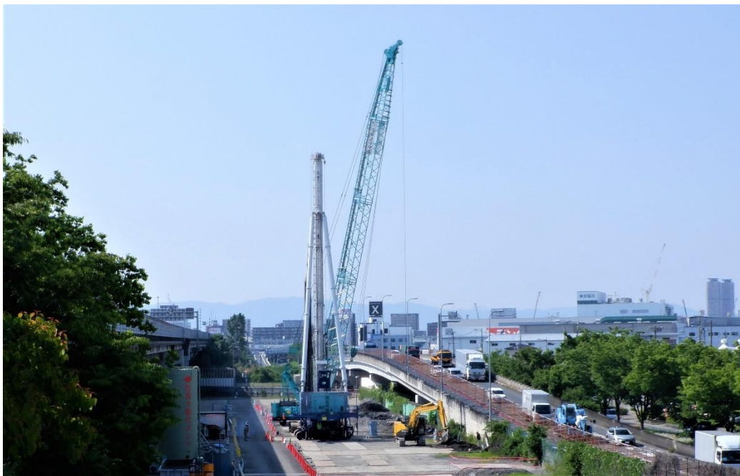
大阪モノレール支柱建設工事（桑才新町工区） （2022年2～7月ガンテツパイル工法施工）
