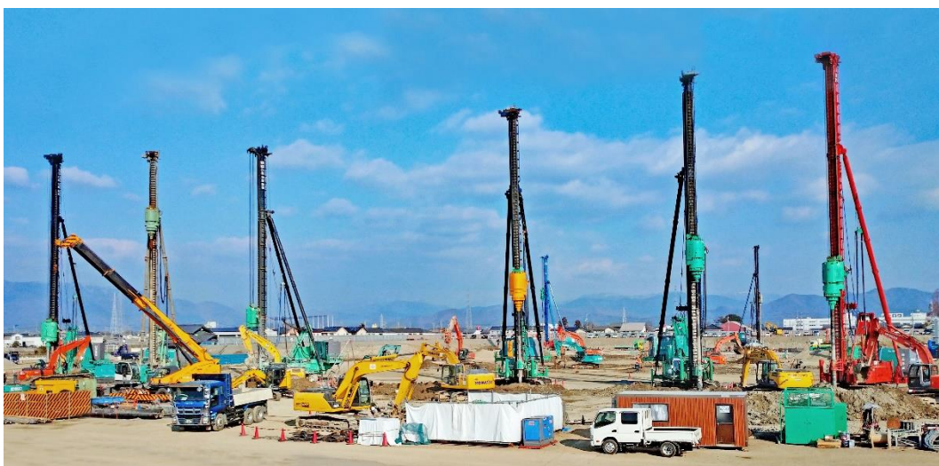
某電子部品メーカー新工場建設工事（岐阜県大野町） （2022年12月～2023年3月テノコラム工法施工）
