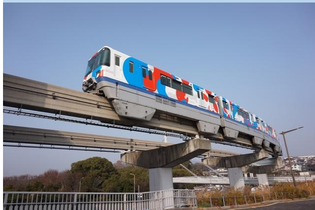
鉄道橋：ガントツパイル工法
