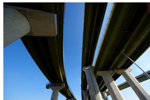
道路橋：ガントツパイル工法
