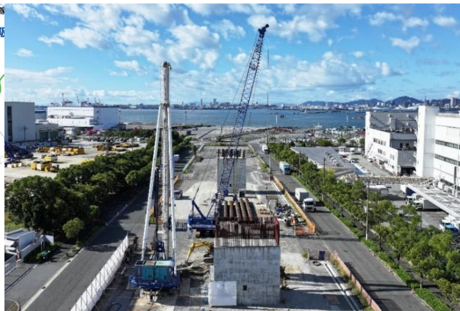
大阪湾岸道路西伸部六甲アイランド西ランプ 基礎工事施工中
