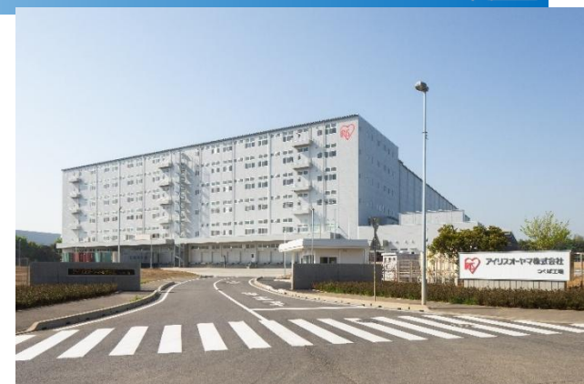
工場：テノコラム工法
