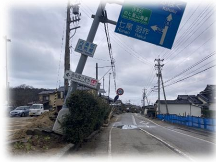
液状化により傾いた道路標識 （2024年能登半島地震）
