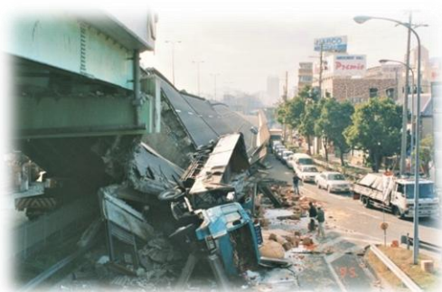
倒壊した道路高架橋（岩屋交差点付近） （1995年阪神・淡路大震災）
