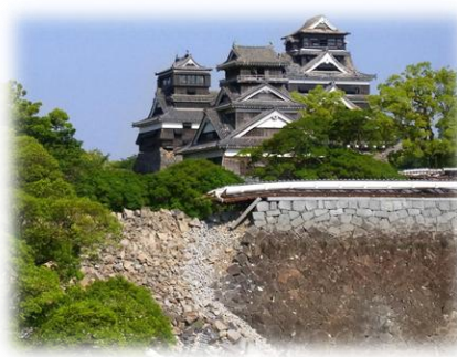
崩落した熊本城の石垣 （2016年熊本地震）
