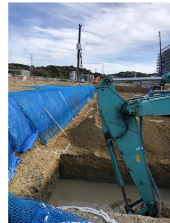
TENOX Q-be とテノコラム併用の施工の様子
