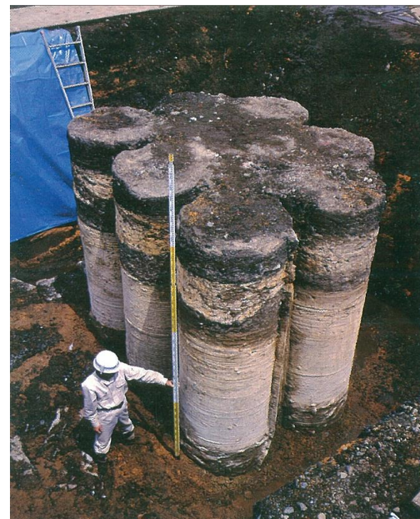
地盤改良工法
