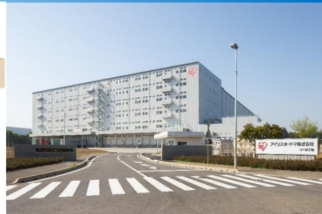
工場：テノコラム工法
