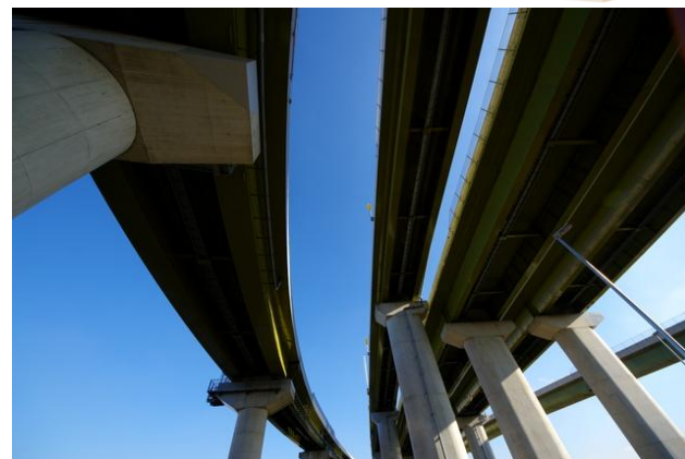
道路橋：ガントツパイル工法
