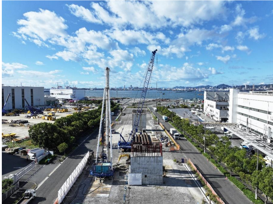
「大阪湾岸道路西伸部六甲アイランド西ランプ基礎工事」 2024年10月～11月施工
