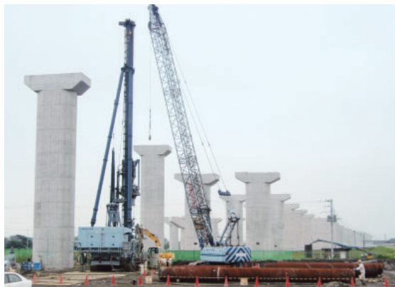
東北自動車道と首都圏中央連絡自動車道（圏央道）を接続する「久喜白岡ジャンクション」においても、ガンテツパイル工法が採用されました。
