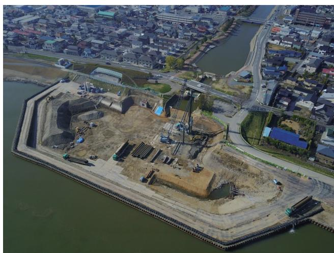
被圧地下水条件でのガンテツパイル工法実績 (水門工事)
