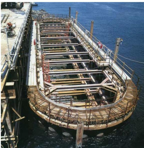
鋼管矢板井筒基礎 (施工後状況)
