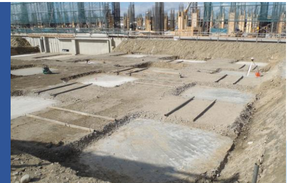
湿式浅層改良工法の施工状況
