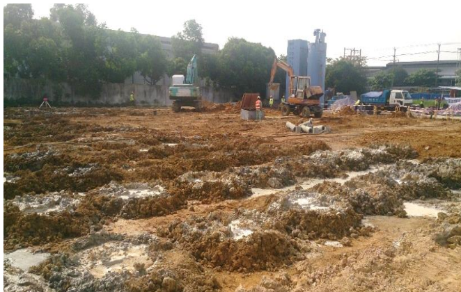
工場建屋の土間部沈下抑止に採用されたテノラム工法
