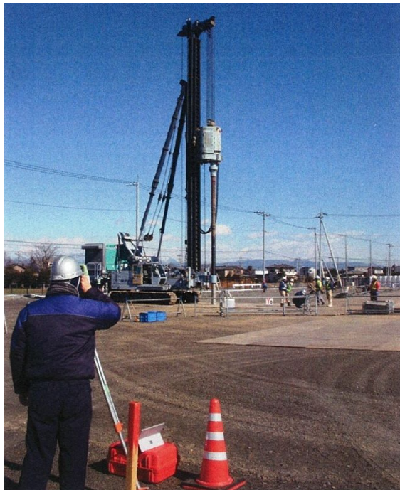
施工位置誘導実験状況
